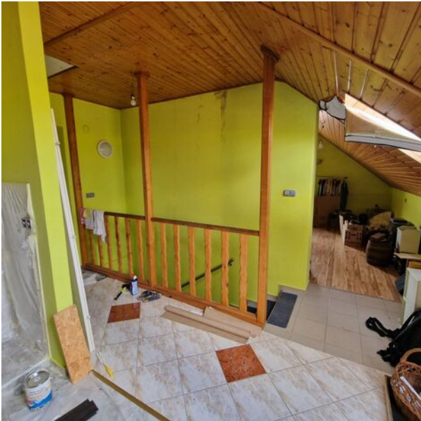
pasillo de arriba
