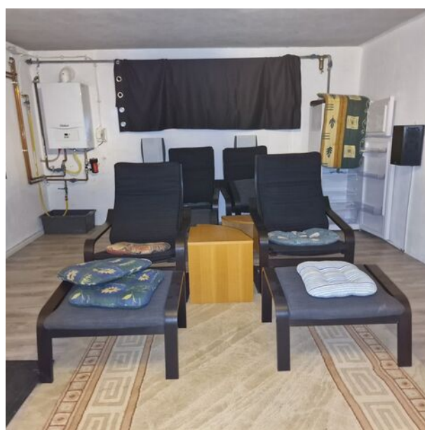
sótano del cine
