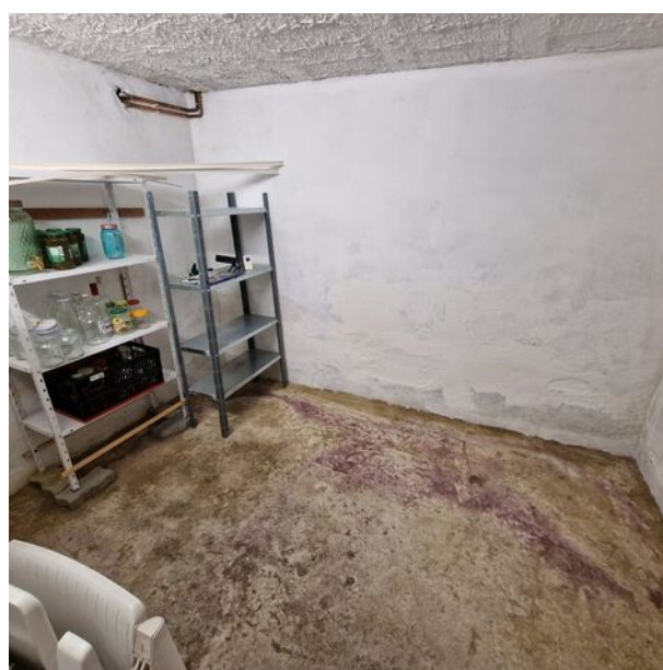
sótano del almacén
