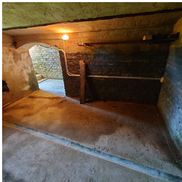
Sótano parcial debajo de la casa principal
