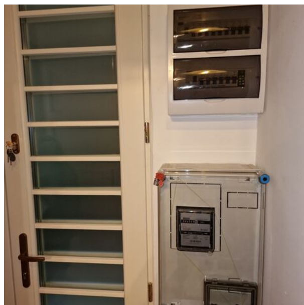
Nueva instalación eléctrica
